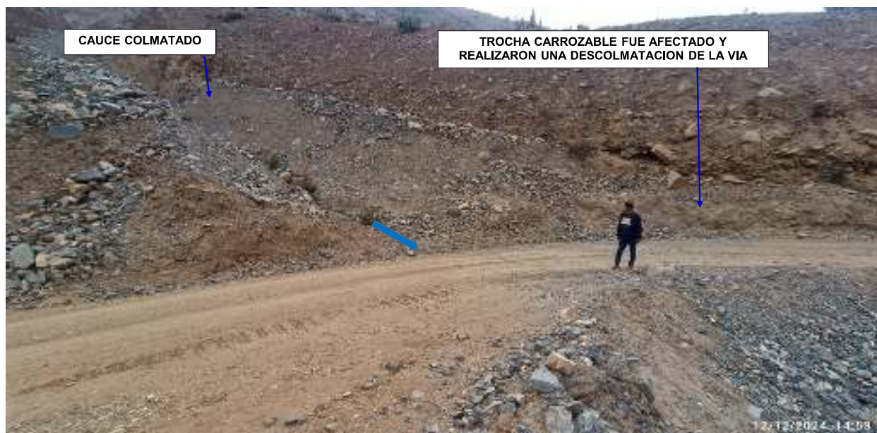
FIGURA N°02: CAUCE COLMATADO PRINCIPALMENTE DE ARENA CON PRESENCIA DE ROCAS DE DIFERENTES TAMAÑOS, CERRO BURRO ALANCHO, AFECTANDO A LA TROCHA CARROZABLE.
