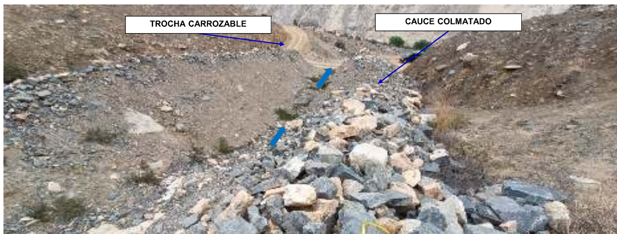
FIGURA N°03: TRAMO DEL CAUCE COLMATADO QUE ESTA PERJUDICANDO LA TROCHA CARROZABLE QUE CONECTA A LOS CENTROS POBLADOS DE CUCAPUNCO Y PISCOCOTO DE LA CAMUNIDAD CAMPESINA DE SUMBILCA.
